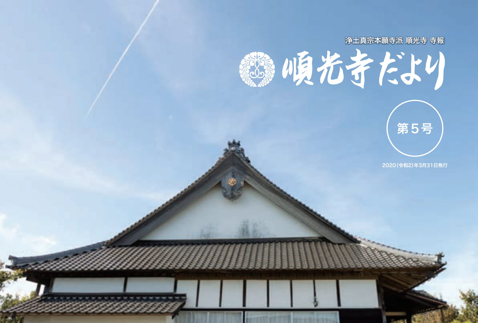
本堂改修工事後の順光寺本堂
