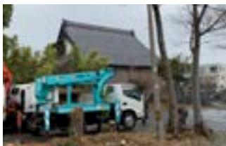
伐採工事の様子
