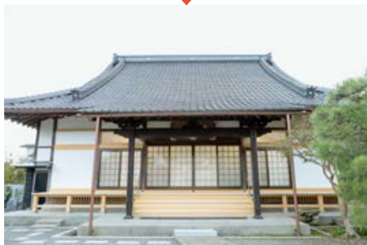
改修工事後の本堂
