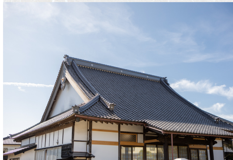
順光寺 本堂（2019年改修工事後）
